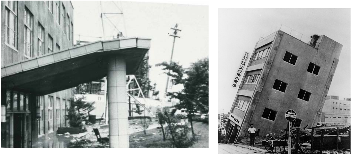
写真1 一見して全壊に相当する基礎構造の被害例
